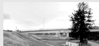
黒塚周辺の河川敷公園整備予定地
