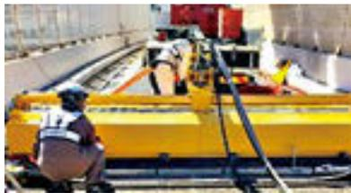
超高圧の水噴流の力でコンクリートなどを削る・剥がす・切る・洗う「ウォータージェット工法」を駆使して、全国各地の橋梁補修工事等で着実に実績を上げています。また、この技術に係わる機械や装置を独自に設計・製作しています。施工と製作を両立出来ることが当社の最大の強みです。
