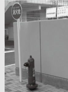
設置された消火栓
