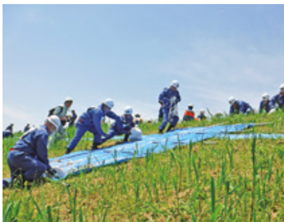
川側の堤防崩壊や透水を防ぐための「シート張り工」
