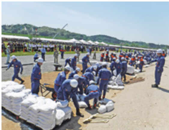
増水した川で堤防の居住側への漏水を抑えるための「月の輪工」
