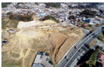
建設が進む「(仮称)メガステージ二本松」(写真中央)と「ホテルルートイン二本松」(写真右上)
