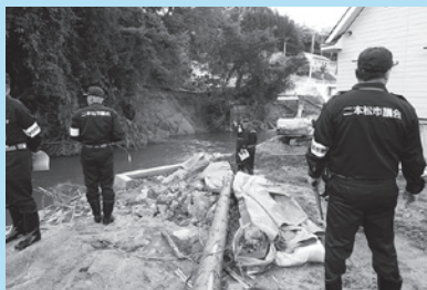
滝の橋付近被災箇所
