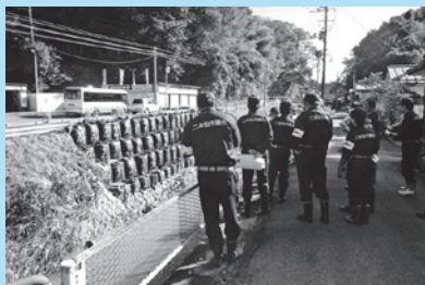
国道459号崩落箇所 (小浜地内)
