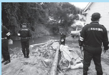
滝の橋付近被災箇所
