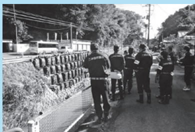
国道459号崩落箇所 (小浜地内)
