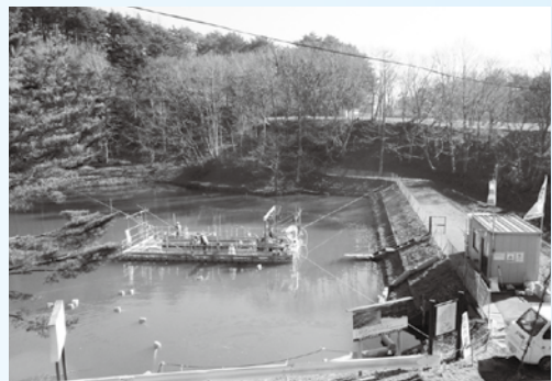
ため池の放射性物質除去対策工実施の様子
