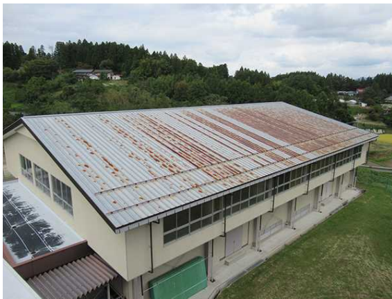
金属屋根の劣化（岩代中学校 体育館）
