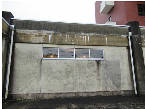
外壁の劣化（東和中学校 校舎棟）
