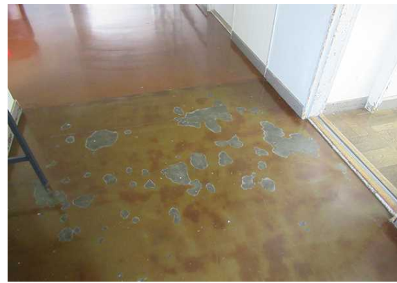
床材の劣化（二本松第二中学校 校舎棟）
