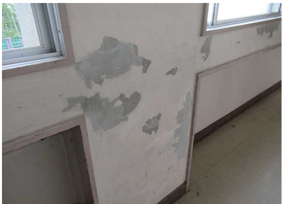
廊下壁の塗装剥がれ（二本松南小学校 校舎棟）
