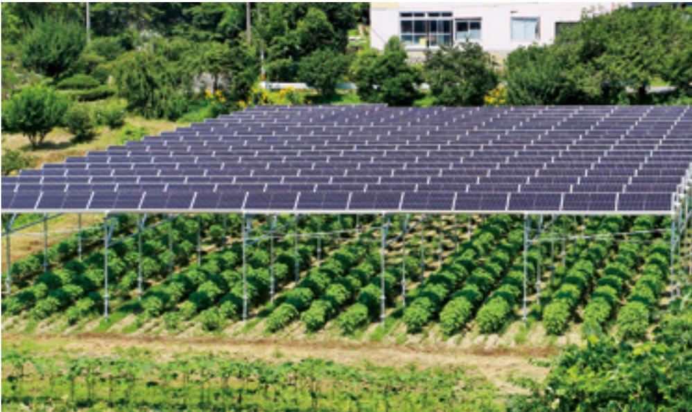
今年3月にゴチカンが東和地域太田地区に設置したソーラーシェアリングによる太陽光発電所(認定容量45.3Kw)。
