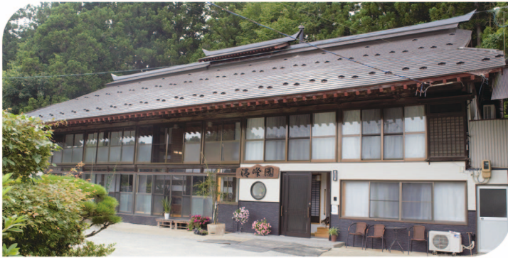
▲貫禄ある佇まい、築100年の古民家
