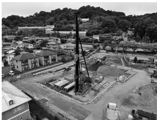
(仮称) 二本松城文化観光施設建設中の様子
