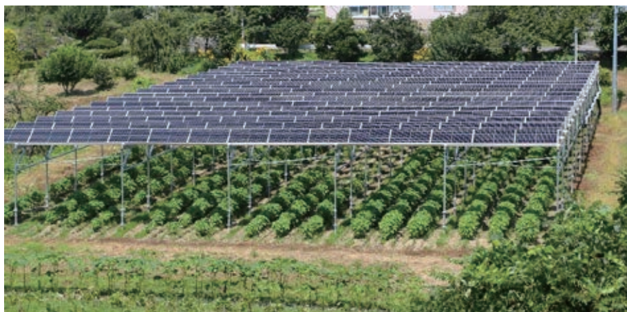
ソーラーシェアリングによる太陽光発電所 (太陽光パネル下部の農地では、「えごま」を栽培)
