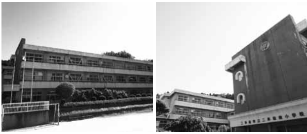
長寿命化改修工事を行う二本松南小学校
