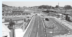
杉田駅周辺整備の様子
