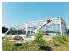
倉庫新設工事
