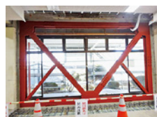
鉄骨枠付耐震ブレース
