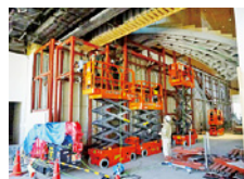
ビル内改装工事
