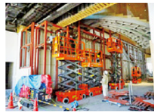
ビル内改装工事
