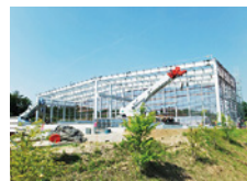
倉庫新設工事
