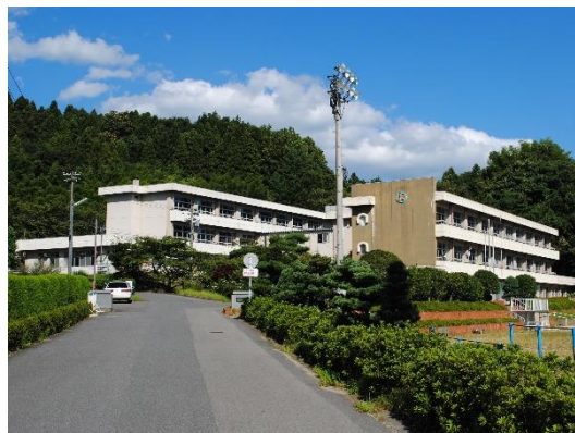
昭和51・52年に建築された二本松南小学校
