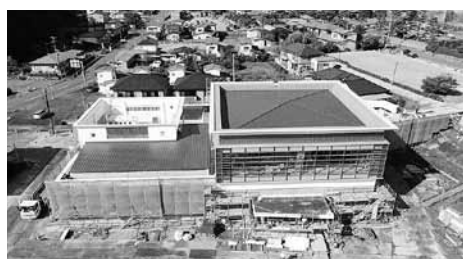
(仮称) 二本松城文化観光施設建設中の様子
