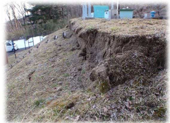
[岳第 1 配水池法面崩落]
