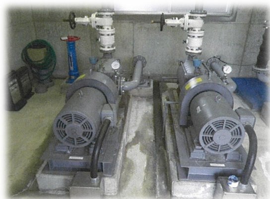
[城山ポンプ場]
