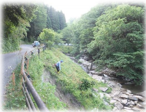
▲ 川法面の草刈り作業
