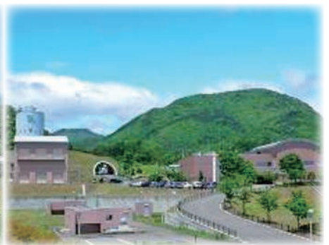
すりかみ浄水場
