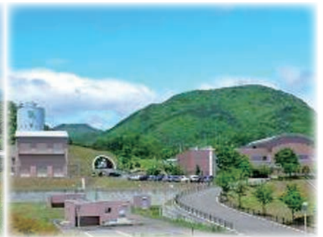
すりかみ浄水場
