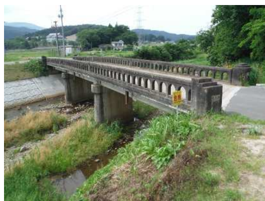
写真：中田橋（昭和38年架設）
