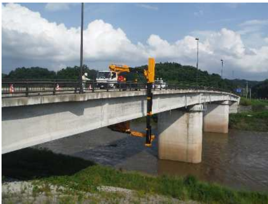
写真：橋梁点検車による点検
