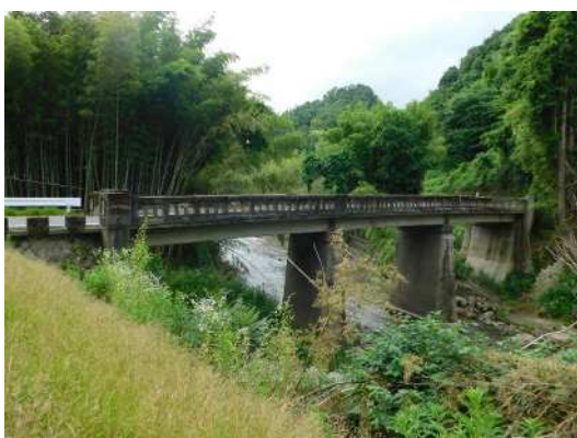
写真：小瀬川橋（昭和26年架設）
