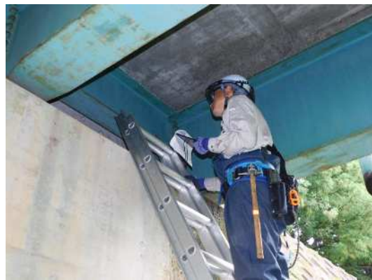
写真：梯子による点検
