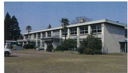
旧下川崎小学校解体工事
