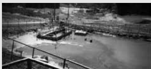
針道上宮/平池対策工
