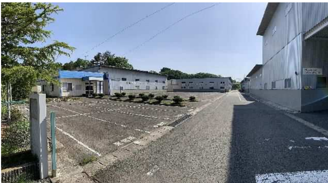
入口より全景
