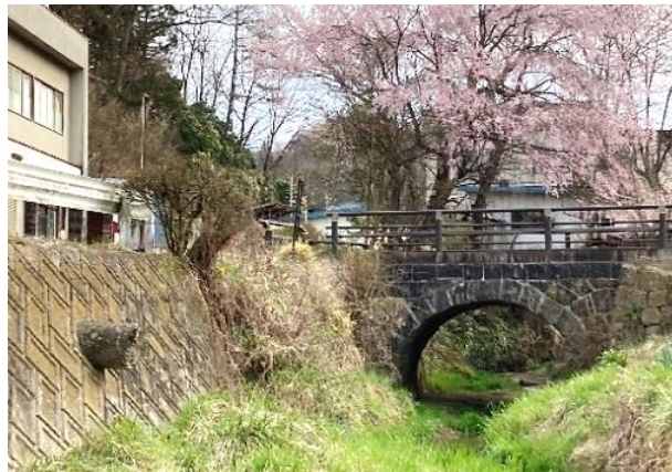
▲道の駅「さくらの郷」の向かい側にある石橋。江戸後期～大正初期に造られた石橋として選奨土木遺産に認定
