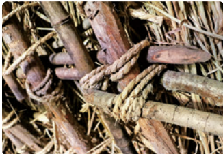
柱と柱、骨組みは縄で固定
