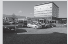
本庁舎前職員駐車場
