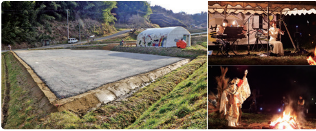
布沢みんなの広場駐車場整備事業(令和5年度) (農業体験や棚田の芸術祭等の実施において、市内、県内および首都圏からの交流体験受け入れのため駐車場を整備)
