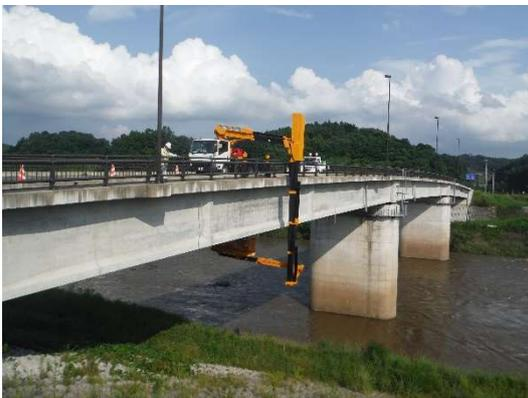
写真：橋梁点検車による点検
