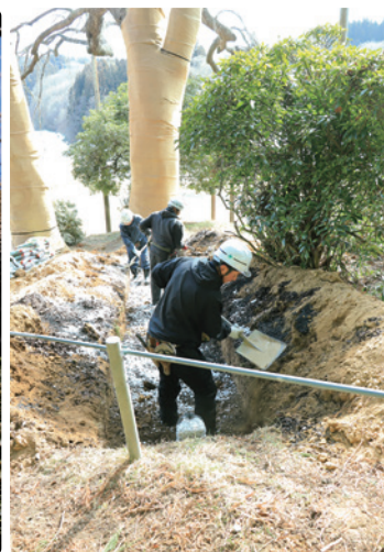
土壌改良作業
