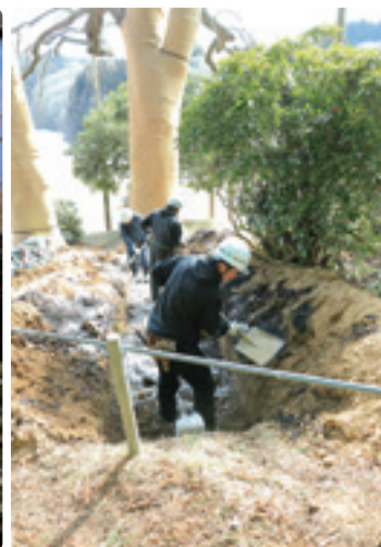
土壌改良作業
