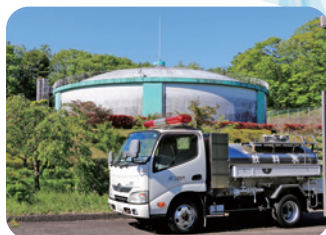
高平配水場と給水車
