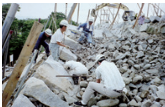
本丸石垣の修復作業状況
