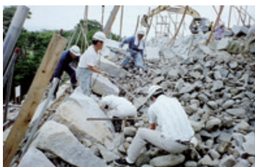
本丸石垣の修復作業状況
