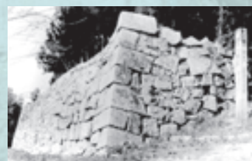
修繕前の本丸石垣
