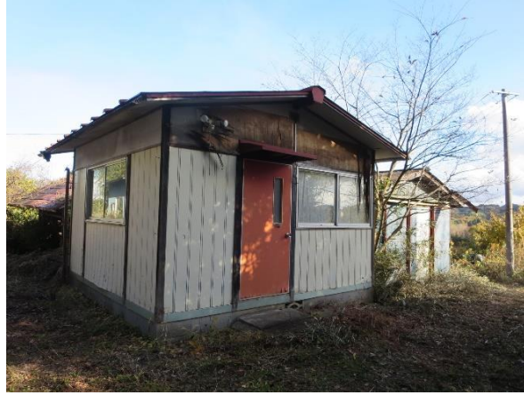
物置(作業小屋)
