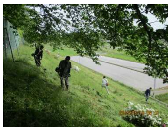
東側法面がさっぱり！
