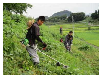
法面（のりめん）もスッキリ！
